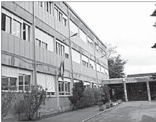
La facciata dell'istituto Zanelli. In alto la preside
